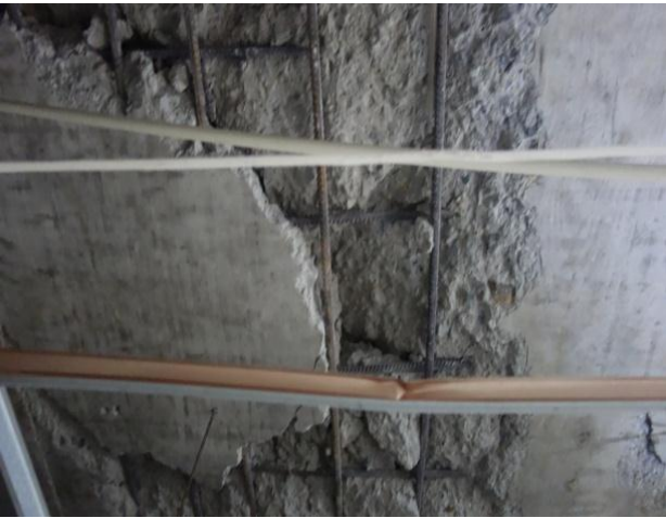
箱涵内部顶板砼碎裂
