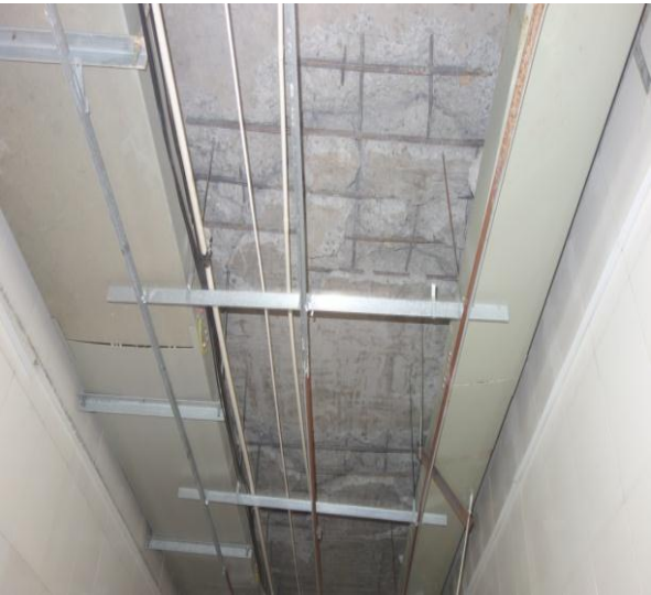
箱涵内部顶板砼碎裂
