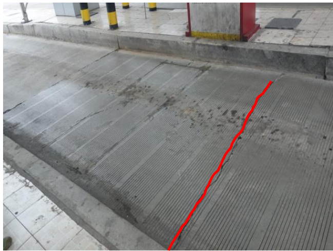
车行道横向开裂1处,长3.2m
